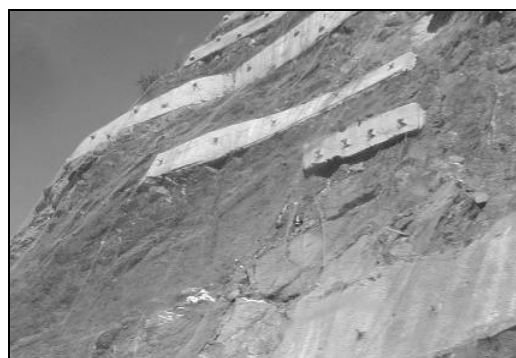
Figura 15.31. Anclajes arriostrados con vigas de atado. Fotografía: autores.
