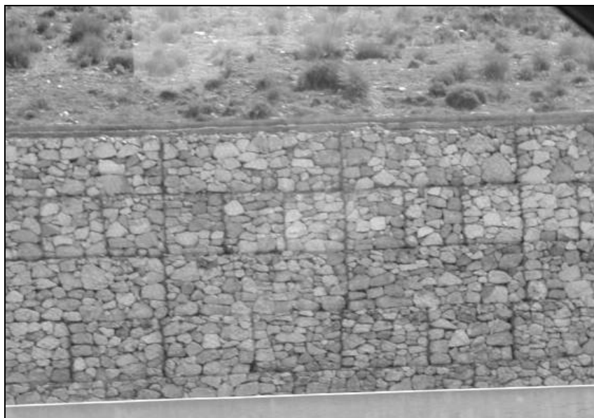
Figura 15.8. Muro de gaviones. Fotografía: autores.
