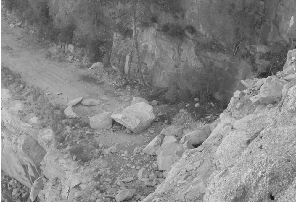
Figura 8.14. Bloque desprendido en una berma de una cantera. Foto: autores.
