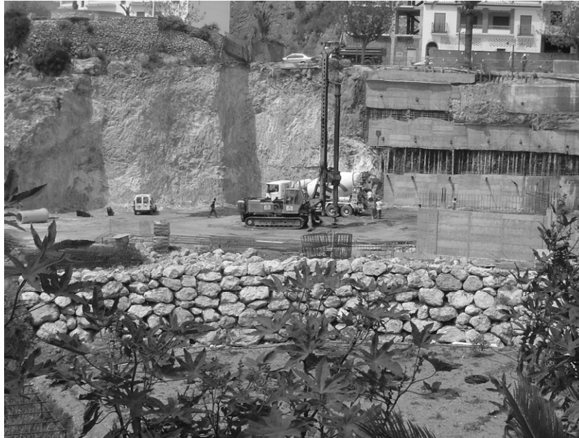
Figura 15.7. Muro de escollera para explanar una zona del terreno. Obsérvese su bajo impacto debido a su integración en el paisaje comparado con los muros de hormigón que también se muestran en la fotografía. Fotografía: autores.
