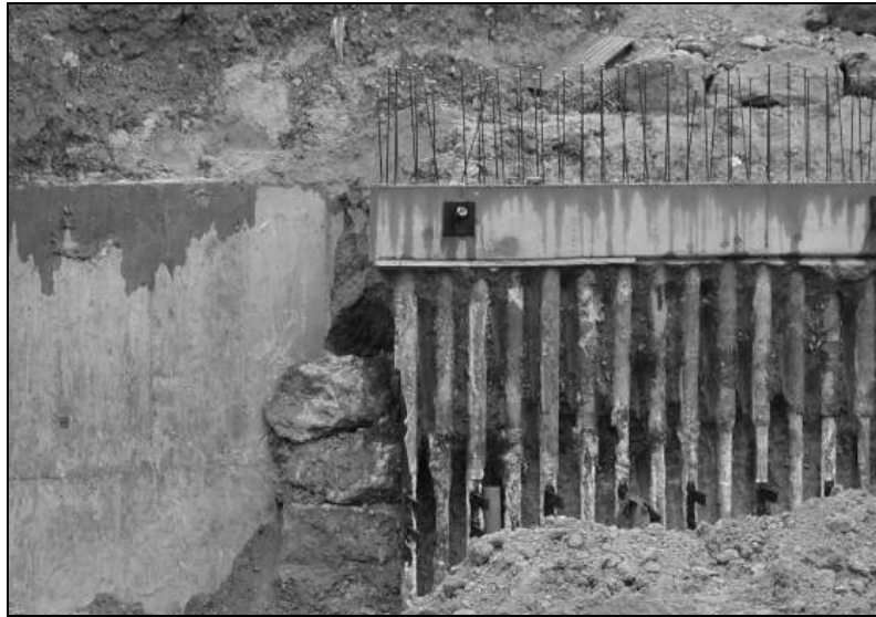
Figura 15.19. Anclado de la viga al talud. Fotografía: autores.
