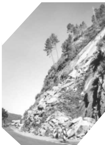
Figura 9.2. Rotura o deslizamiento plano en la carretera entre Monforte de Lemos y Orense. Foto: autores.
