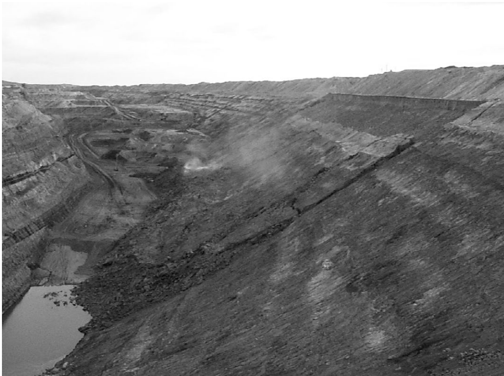
Figura 8.12. Fotografía de una rotura por discontinuidades paralelas al talud en la corta de carbón Leigh Creek en Australia. Fotografía de David Lucas.
