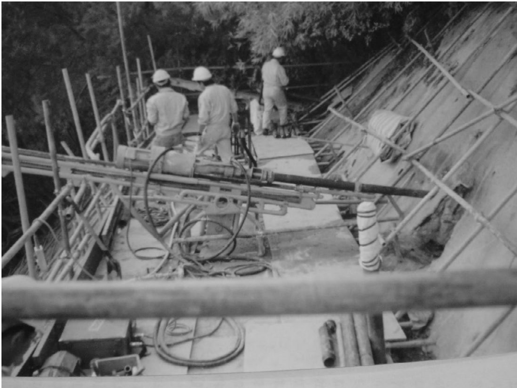
Figura 15.25. Cosido con micropilotes de un talud en Hong-Kong. Fotografía: autores.
