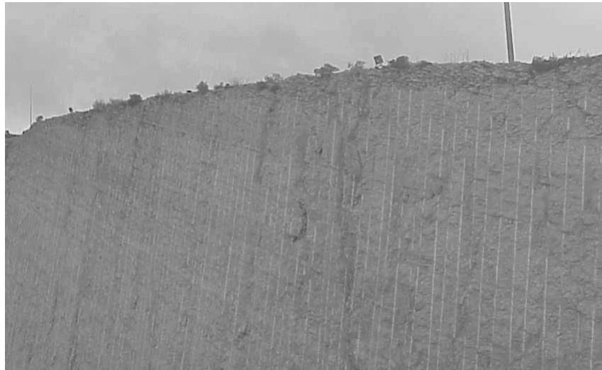
Figura 17.18. Resultados de la aplicación de precorte en una explotación. Cortesía de la cantera de Echaury y Tiebas, donde se realizó la fotografía.
