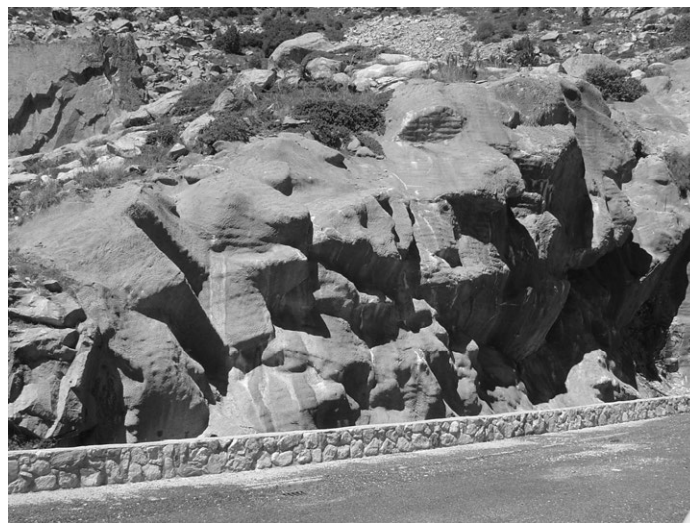
Figura 15.35. Talud gunitado en un macizo rocoso. Fotografía: autores.
