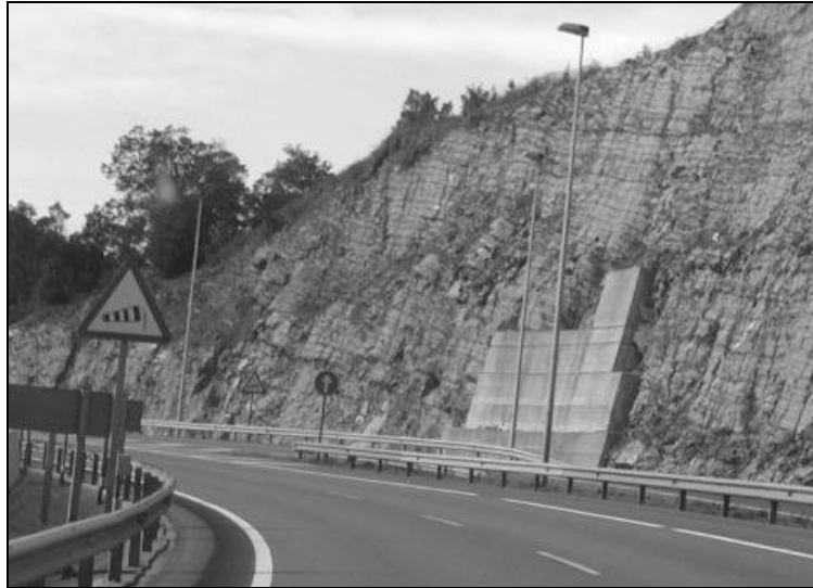
Figura 15.4. Muro de hormigón armado en macizo rocoso.
