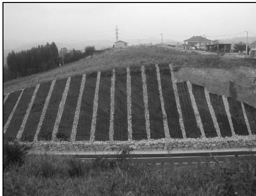
a) Zanjas transversales
