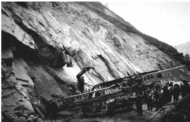
Figura 8.22. Instalación de un sistema de anclajes en un talud en roca.
